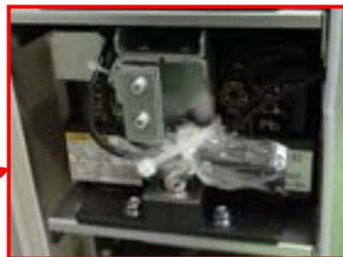
接続されていないコネクタは、透明袋にて包装していますので外して接続してください。
