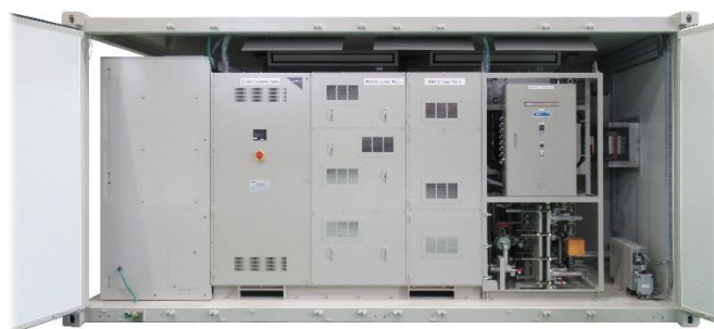
水素製造用整流器コンテナソリューション例
