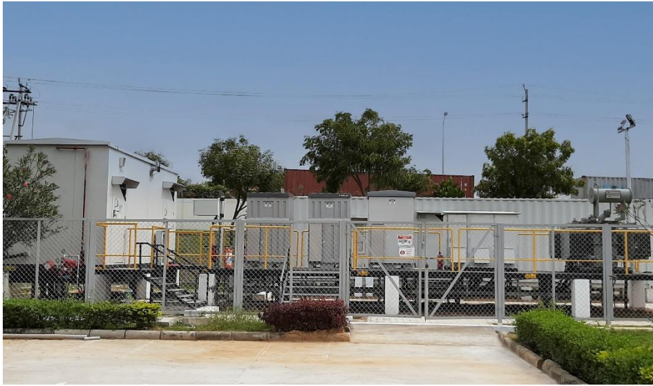
TMEiC インド工場 蓄電池システムラボ
