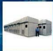
図1 MPC方式高圧瞬低補償装置の外観（7000kVA 10秒補償）
