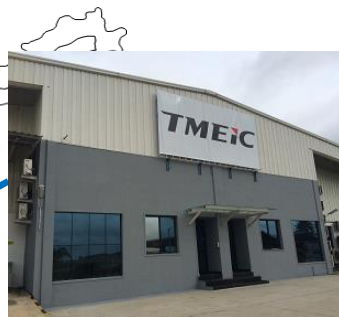
図2 パワーエレクトロニクス工場 カルナタカ州 バンガロール市 (稼働中)
